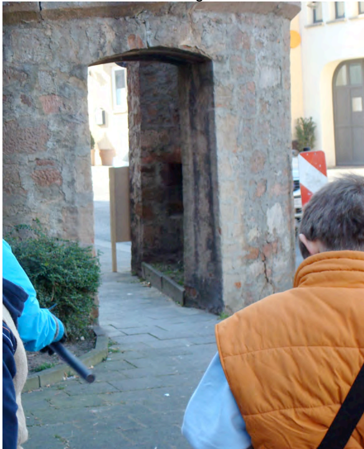
Ostturm des ehemaligen Unteren Tores
