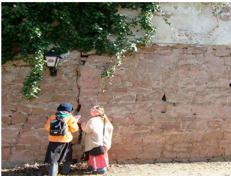
Erhaltene Teile der ehemaligen Ortsbefestigung im Osten Unterer Teil der abgebildeten Mauer
