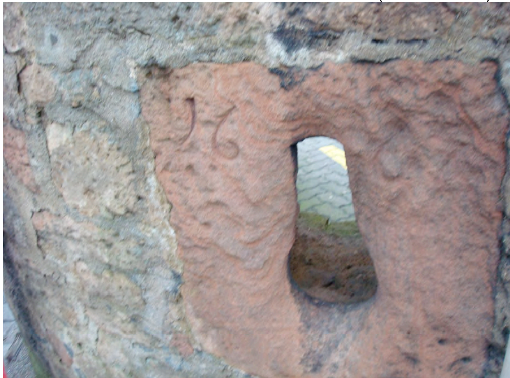
Schlüsselscharte am Westturm des Unteren Tores ( Außenmauer )
