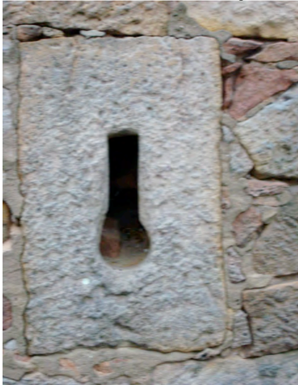
Schlüsselscharte am Ostturm des ehemaligen Oberen Tores an der Pfortengasse
