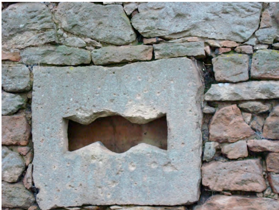
Maulscharte an der Mauerpartie an der Jahnstraße - östlich des Ostturmes des ehemaligen Tores an der Pfortengasse
