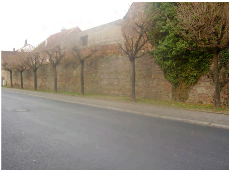
Mauerabschnitt an der Jahnstraße – Richtung Pfortengasse
