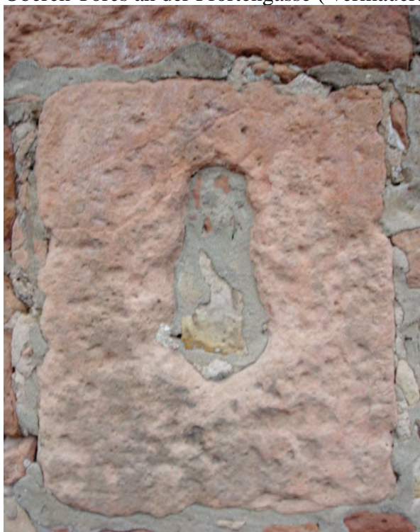
Schlüsselscharte am Westturm des ehemaligen Oberen Tores an der Pfortengasse ( vermauert )
