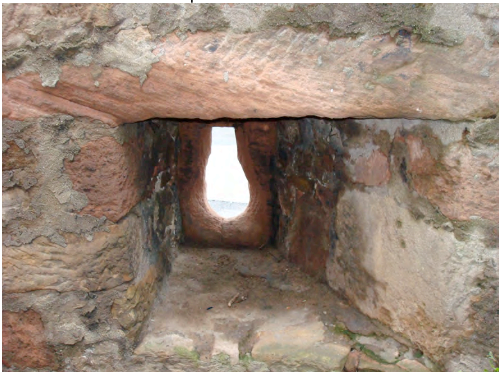
Schlüsselscharte am Westturm des ehemaligen Unteren Tores ( Innenmauer ) an der Hauptstraße
