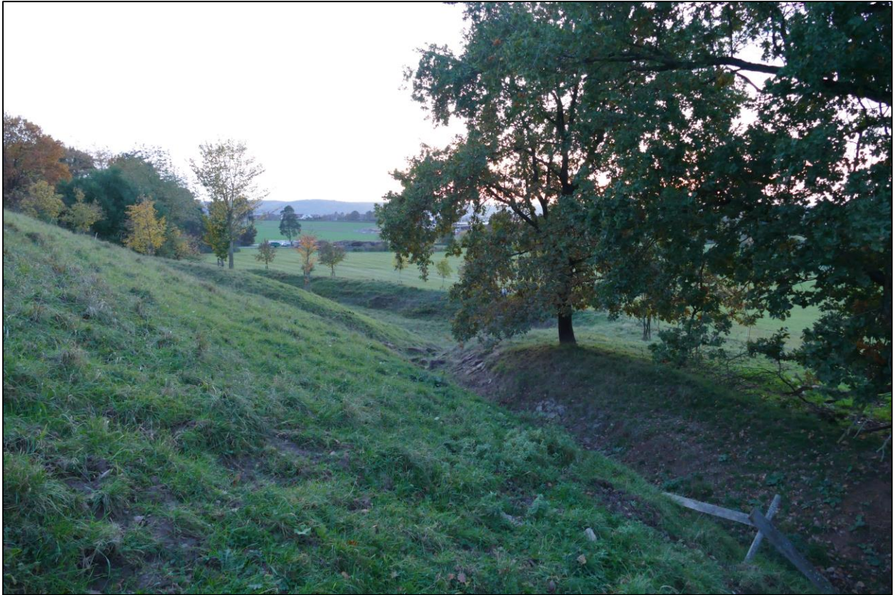
Abb. 9: Nordwestlicher Fuß der Deponie. Zu erkennen ist die Entwässerungsmulde sowie das Sickerbecken im Hintergrund (IBU, 2023)
