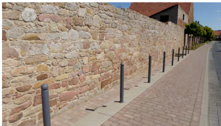
Restauriertes Mauerteil an der Jahnstraße
