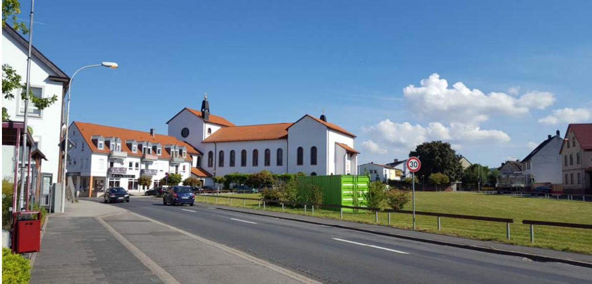
Abb. 2: Bestandsgebäude nordöstlich des Planungsgebietes (Foto: Jocham, September 2016)
