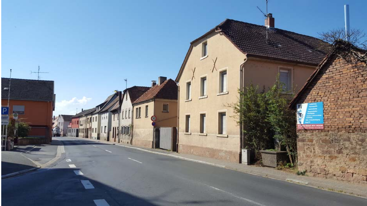
Abb. 4: Bestandsgebäude auf der Planungsfläche (Foto: Jocham, September 2016)
