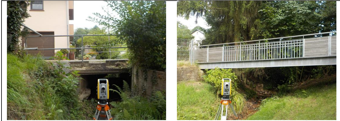
Abbildung 15: Geländertypen, links Brückenplatte maßgebend, rechts Geländeroberkante maßgebend
