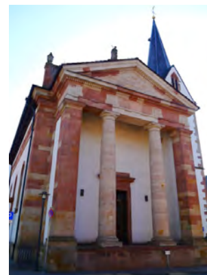
nach dem Abbau der Treppe
