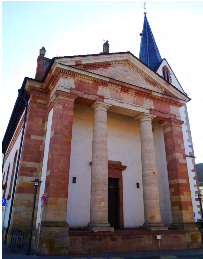
Hauptfassade im Norden (ohne Freitreppe)
