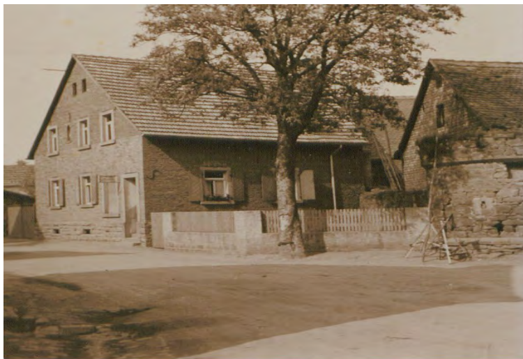
Blick auf die Jahnstraße mit genanntem Wohnhaus vor dem Bau der neuen Pfarrkirche
