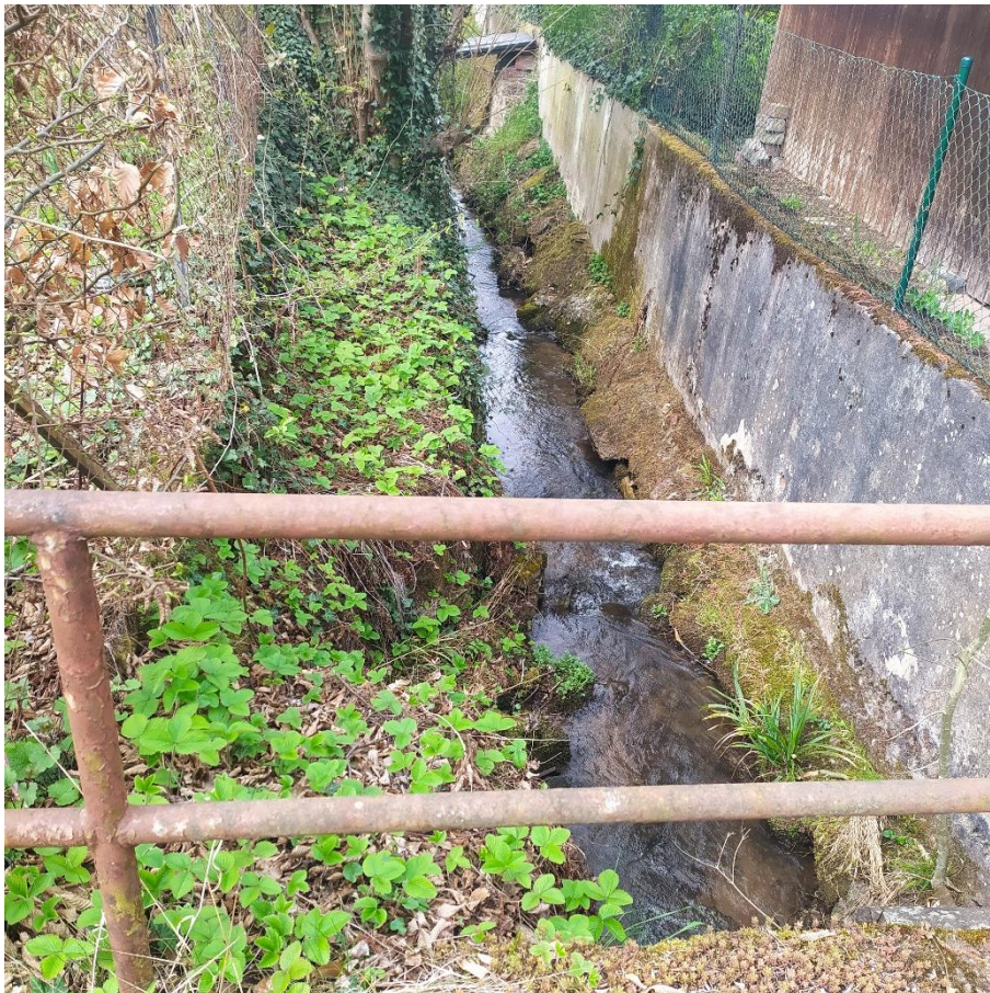
Abb.5: Der Sodener Bach (nördliche Grundstücksgrenze)
