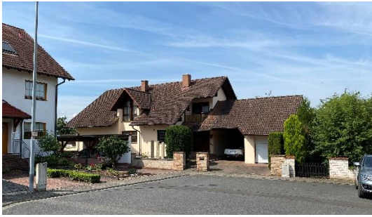
Westlicher Abschluss Südring 28
