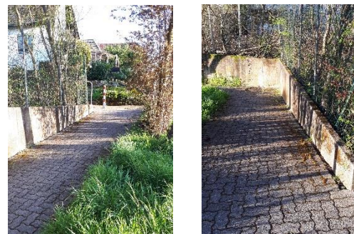
Stichweg nach Westen, Stützwand
