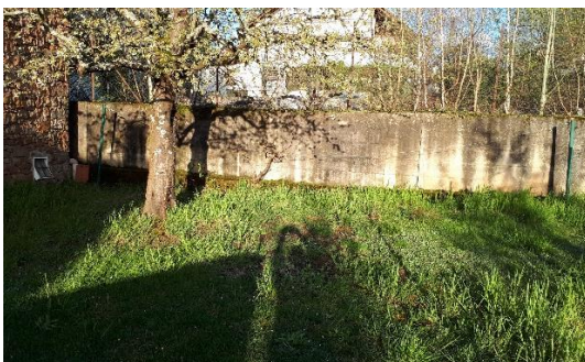
Stützwand zwischen FINr. 5207 und 4521
