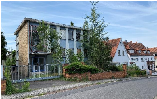
Blumenstr. 4, ehem. Kleiderfabrik
