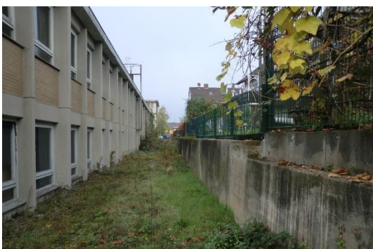
Stützwand FINr. 5207 zur Ostseite
