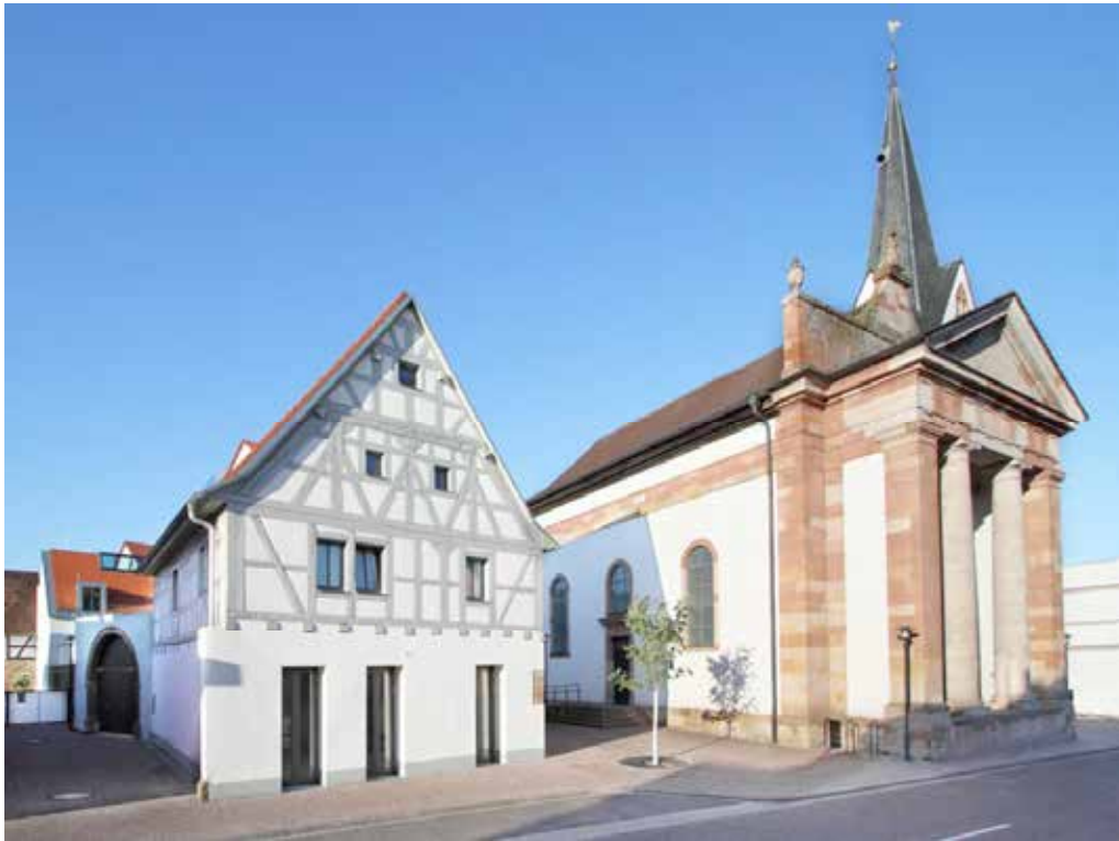
Ensemble: Haus der Begegnung mit St. Anna-Kirche Spessartstraße - Sulzbach am Main
