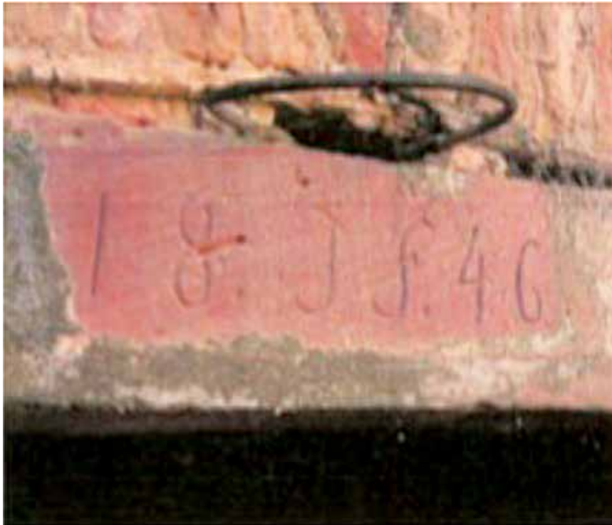
im rückwärtigen Bereich
