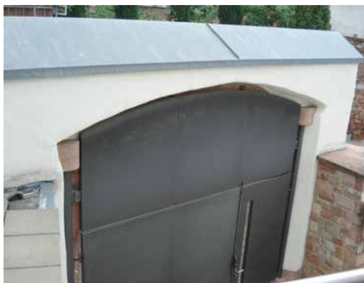
Das sanierte Tor vom Hof aus
