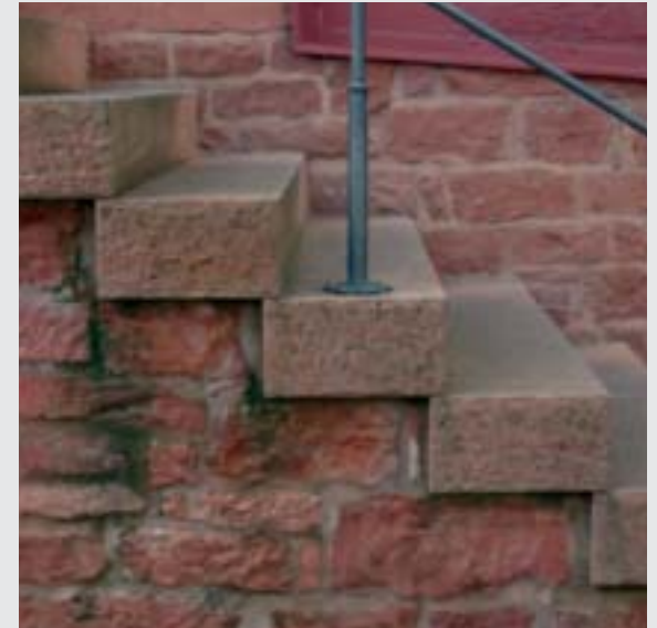
Außentreppe aus Sandstein
