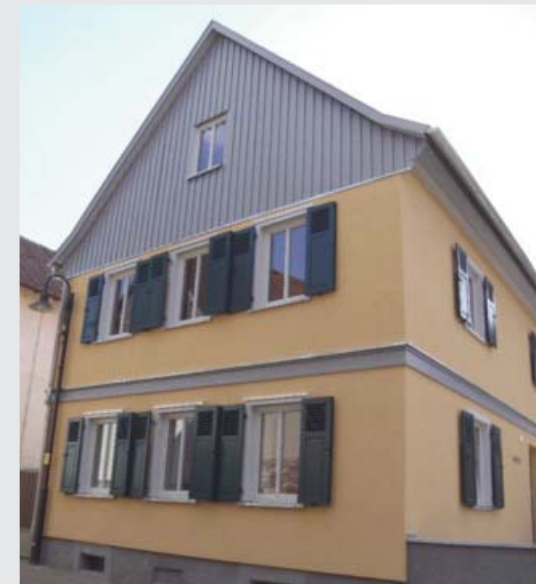
Putzfassade - senkrechte Holzschalung im Giebelbereich
