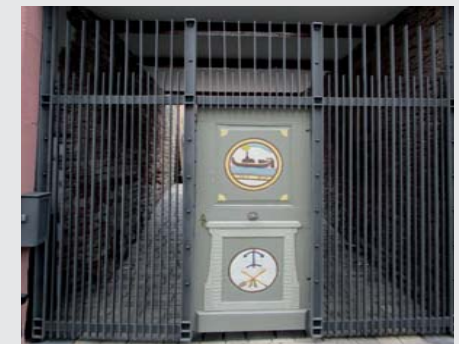
künstlerisch gestaltetes neuzeitliches Stabgittertor mit integrierter historischer Türe
