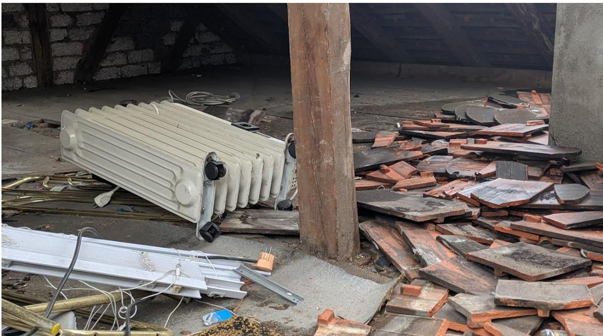
Abbildung 9: Blick in den nur noch kleinflächig bedeckten Dachstuhl, die Feuchtigkeit hat den Bodenbelag bereits angegriffen.
