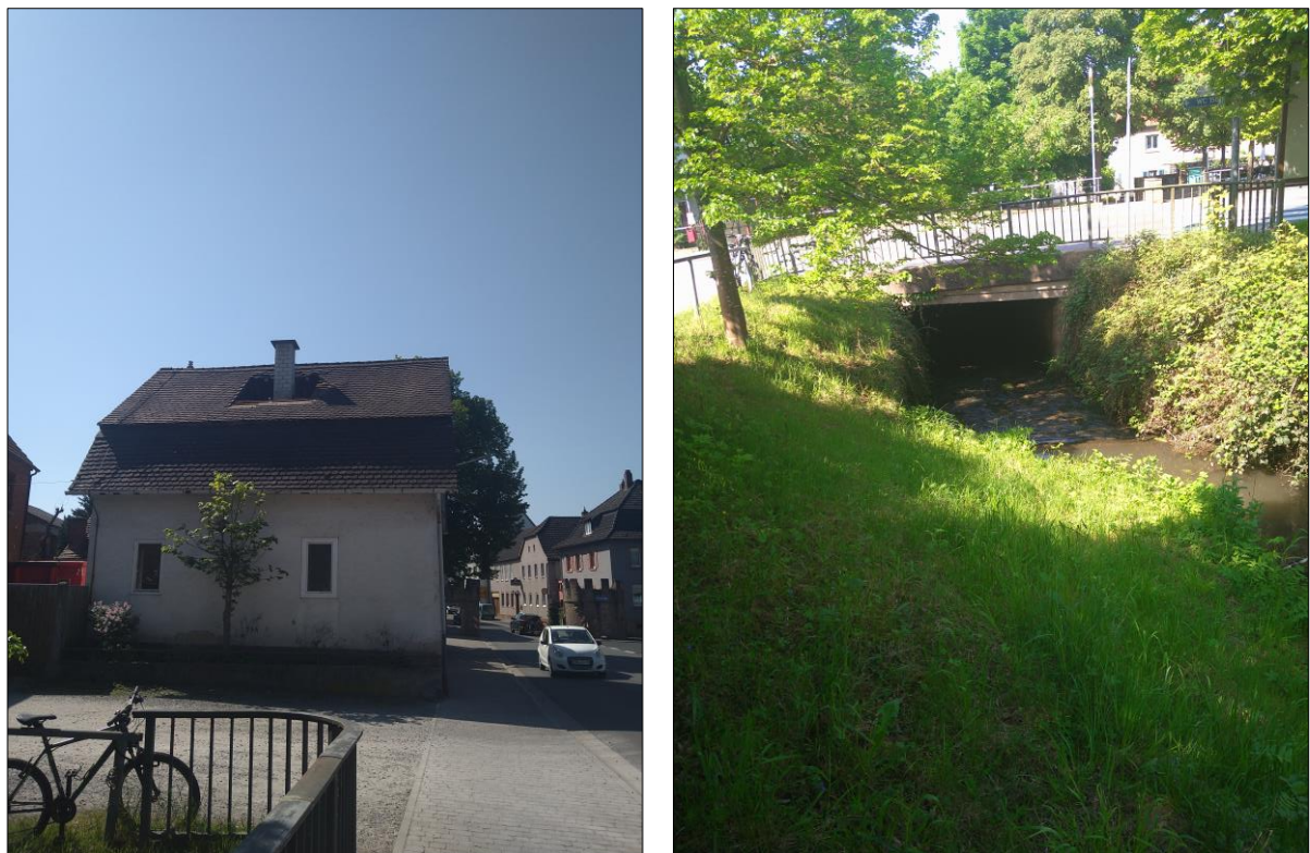
Abbildung 16: Blick auf das Gebäude an der Bahnhofstraße 4 (links) und eine Teilverrohrung des Sulzbachs (rechts) (IBU, 2025).
